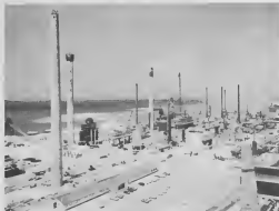
HDS Facilities, Phase II, under construction. Facilidad HDS-II bajo construcción.
